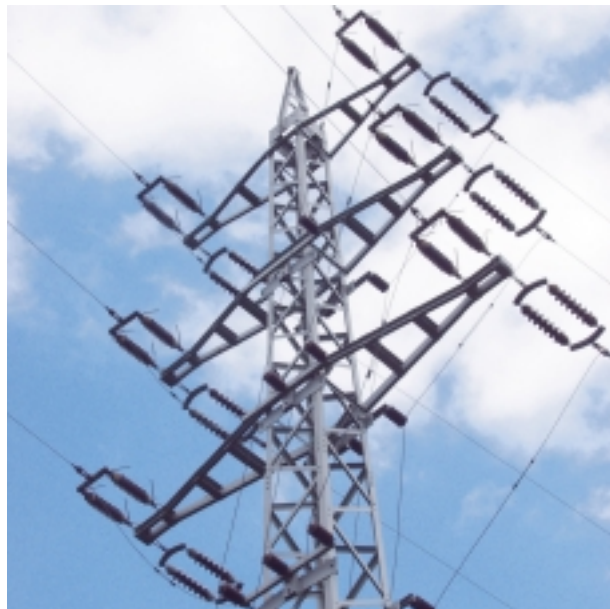
Hochspannungsisolatoren auf Basis EPDM oder Silicon High Voltage Insulator based on EPDM or silicone
